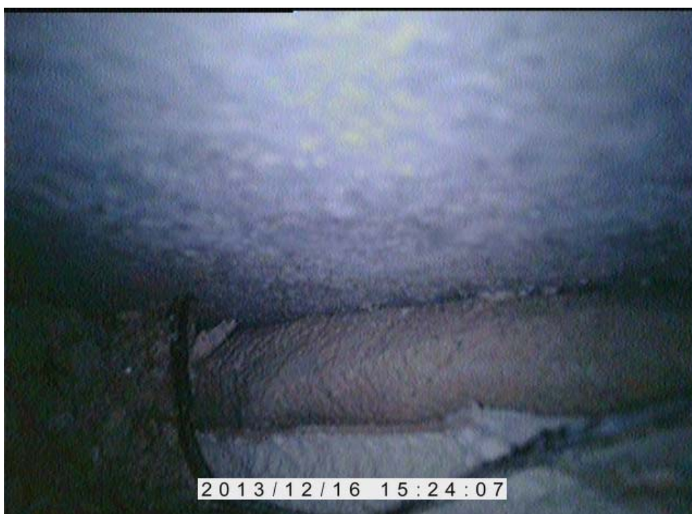
Bild mit Inspektionskamera auf Verklebung Rigips
