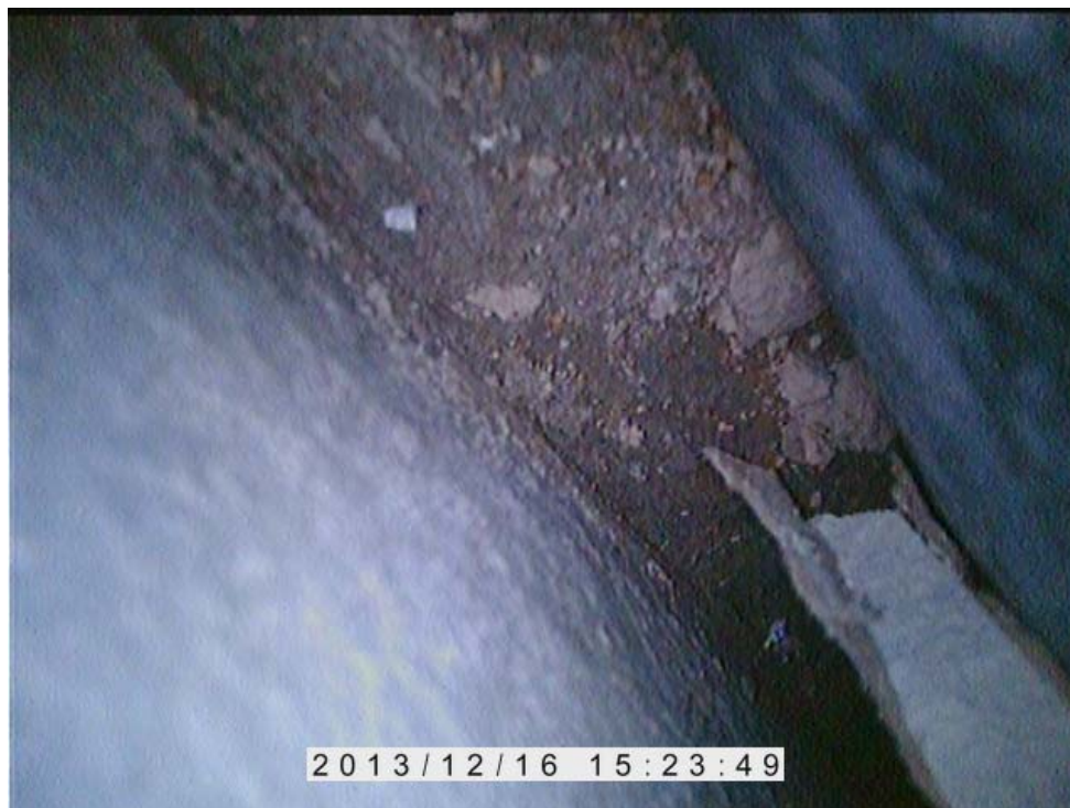
Bild mit Inspektionskamera auf Rohboden und Wand
